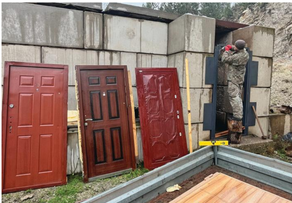
5. ábra. A biztonsági ajtó rögzítőkeretének összeszerelése beállítása (Szalkai L. és Daruka N. felvétele)
