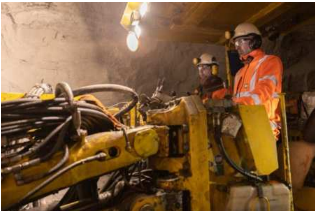
Obr.5 – Elektro-hydraulická vrtná súprava Boomer 281 1B v akcii na bani Fortuna 10
