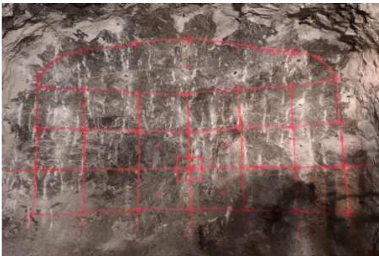
Obr.4 – Nakreslená vrtná schéma v čelbe 9
