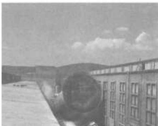
3. Egy siló irányba döntése szűk helyre
