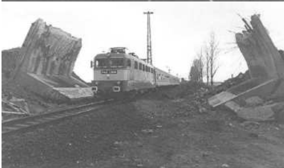
4. Vasúti felüljáró robbantása
