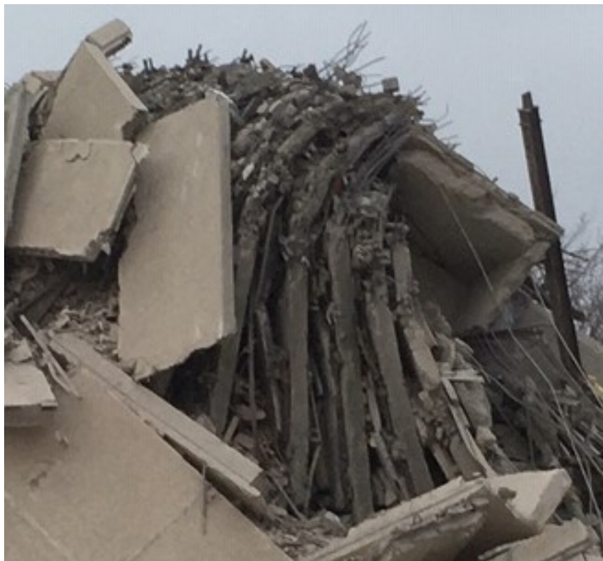
6. kép Az épület döntési irányval ellentétes oldala
