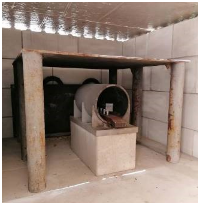
2.kép: A robbantó bunker belseje az acél védművekkel.
