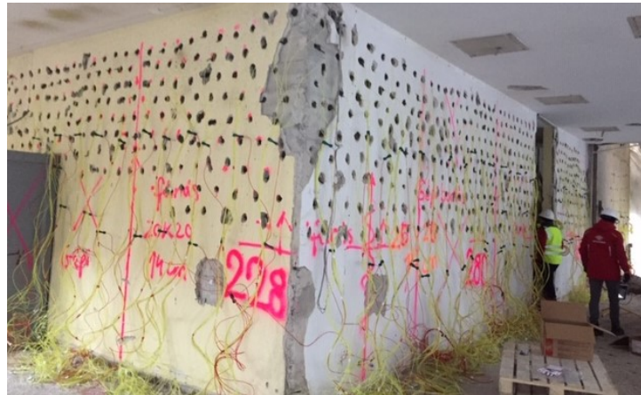
2. kép Jellemző lyuktelepítés a vékony falaknál
