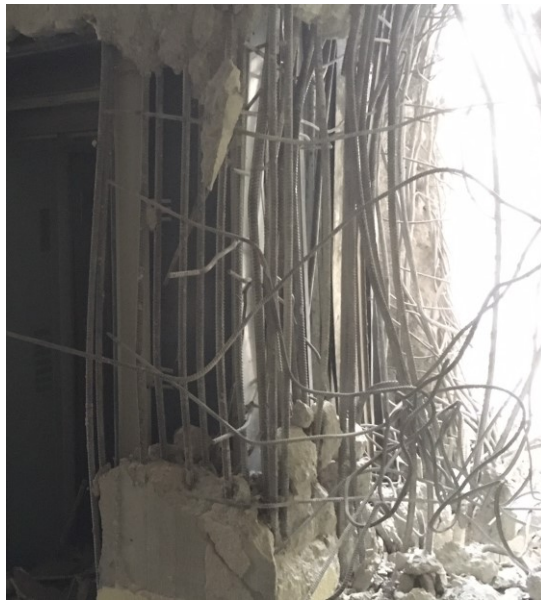
1.kép A liftakna 0,1 m vastag falainak vasalása
